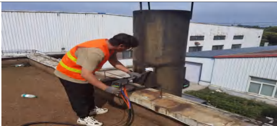
燃气锅炉排气筒 DA001
