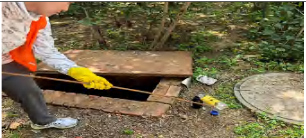
厂区废水总排口
