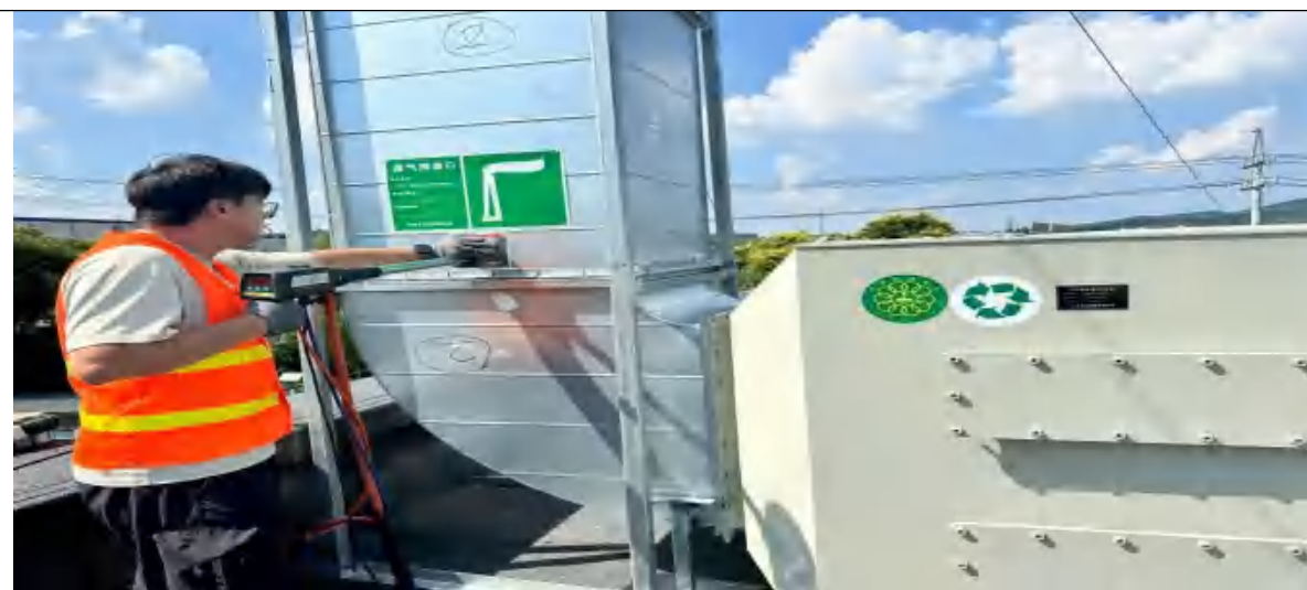
实验楼排气筒 DA004
