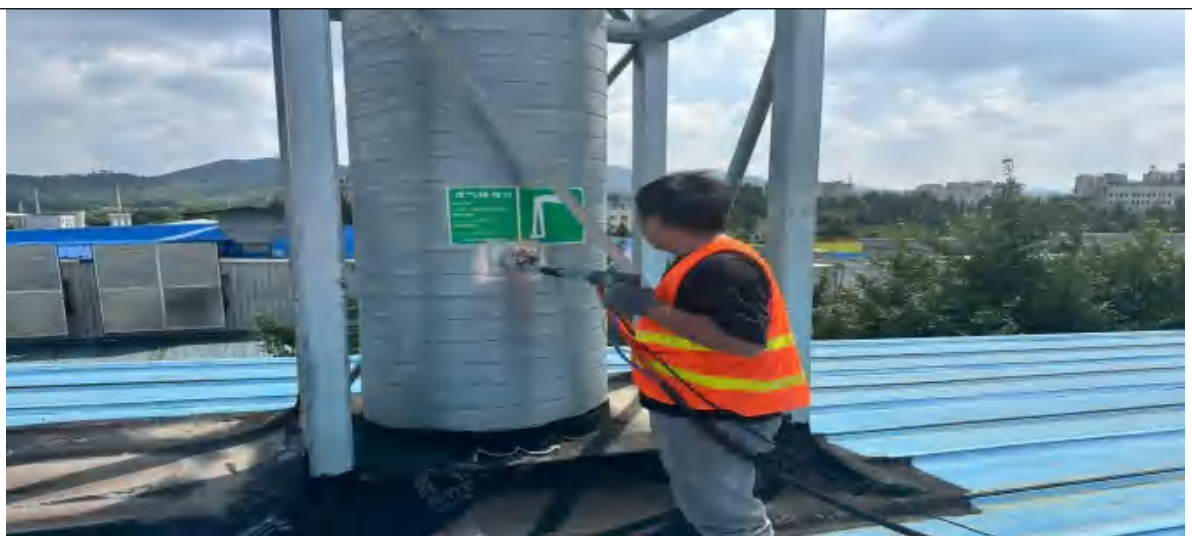
一车间排气筒 6DA011
