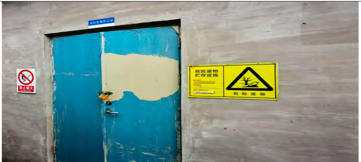
危险废物暂存间
