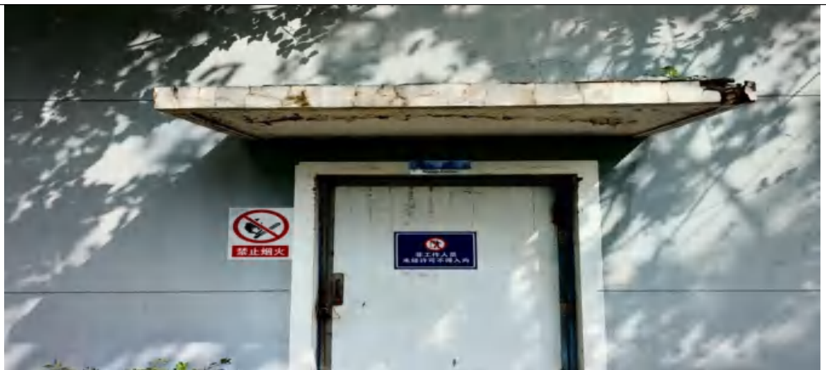
长生公司污水处理站
