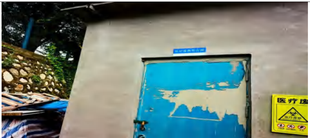
医疗废物暂存间
