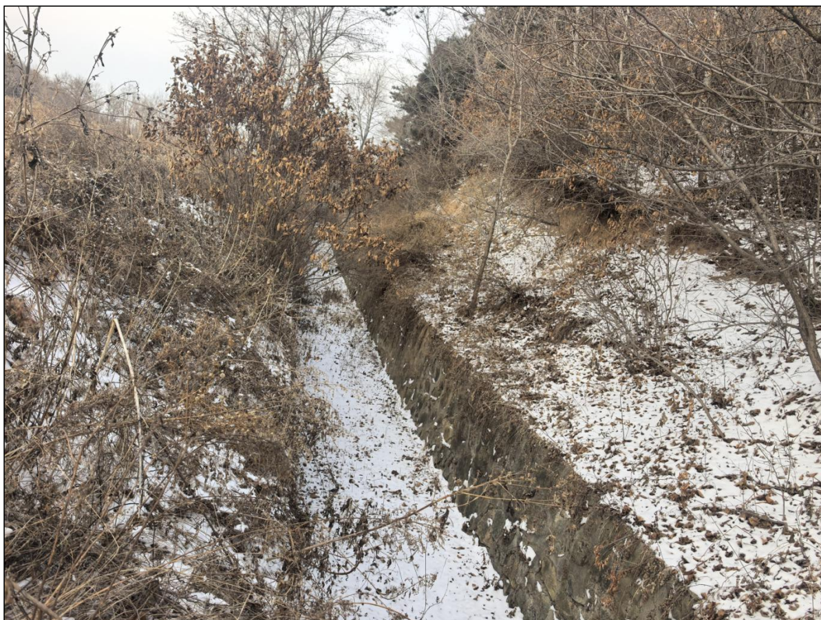
图 2-7 溢洪道过流段
