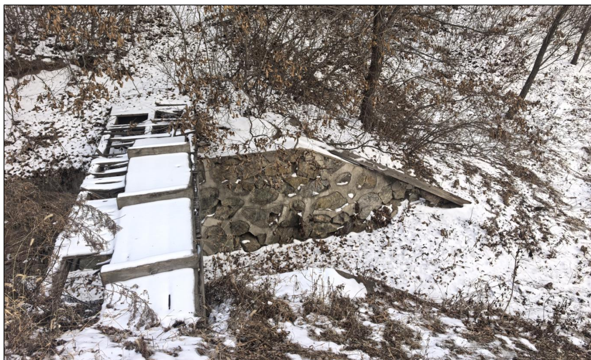
图 2-6 溢洪道进水口
