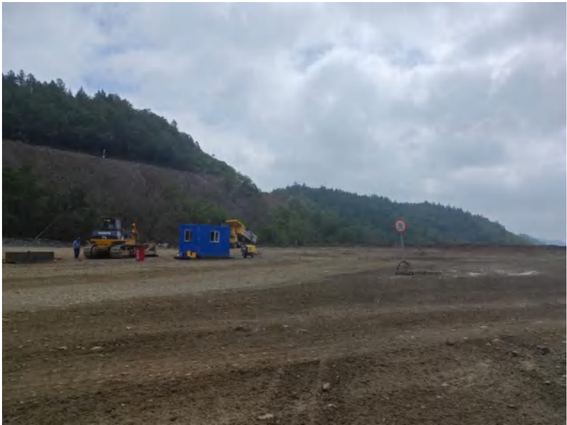
图 25:2 号排土场反坡和挡墙
