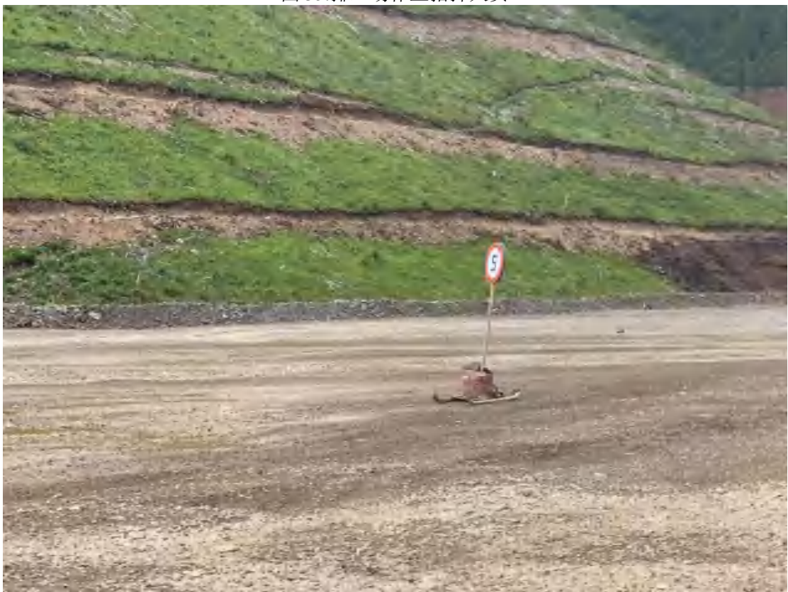
图 36:排土场道路限速标识
