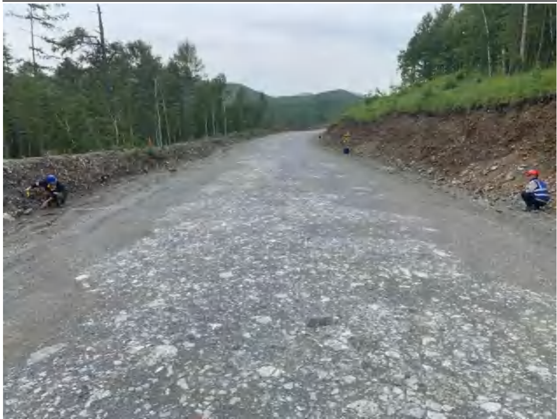
图 17:新建通往 2 号排土场运输道路
