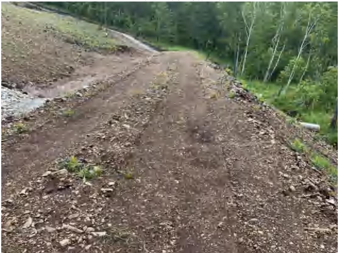
图 34:3 号排土场车拦渣坝
