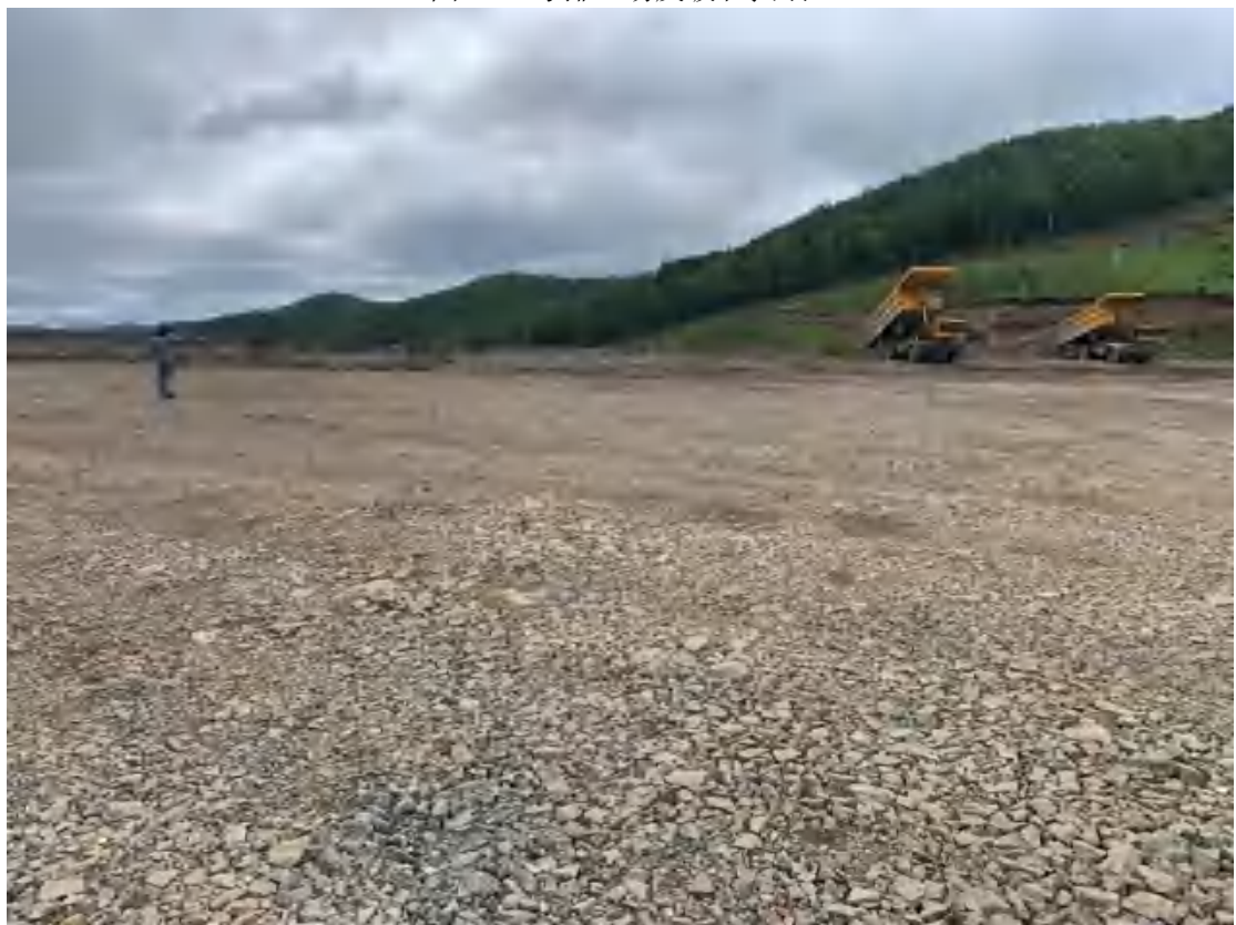
图 26:3 号排土场反坡和挡墙
