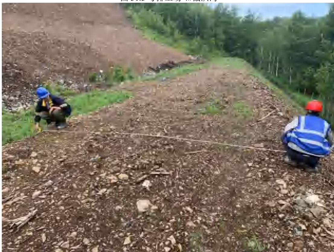
图 32:2 号排土场北侧拦渣坝
