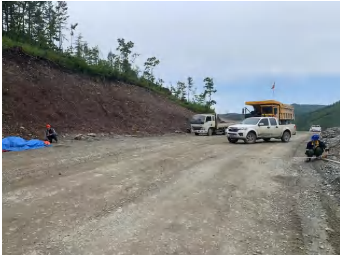
图 16:新建通往 2 号排土场运输道路测量
