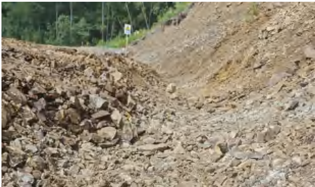
图 13:运输道路排水沟
