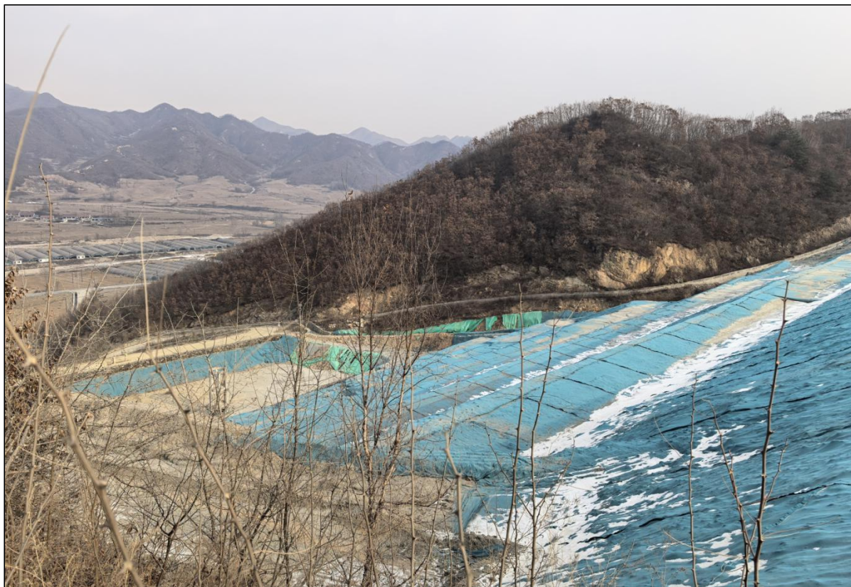
图 2-7 下部临时边坡（二）
