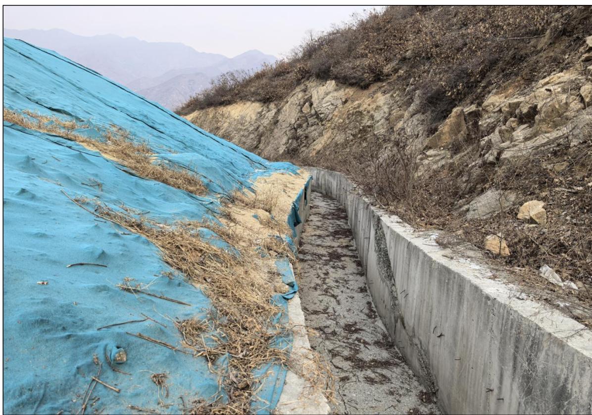
图 2-11 混凝土衬砌段截洪沟（尾砂堆积面以下）
