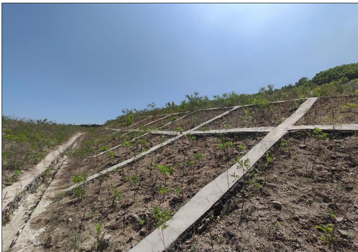
图 2-4 上部永久边坡（一）
