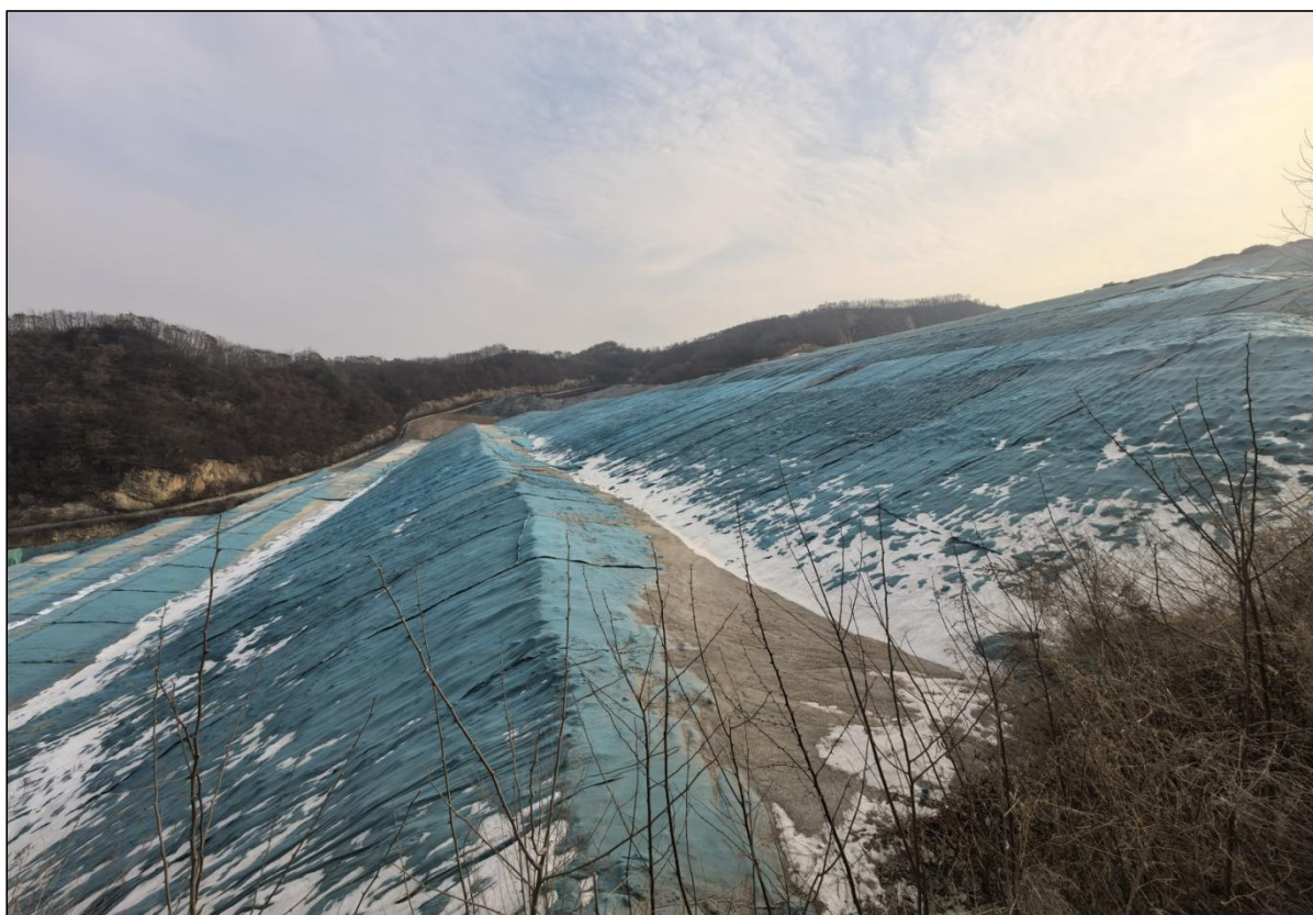
图 2-6 下部临时边坡（一）
