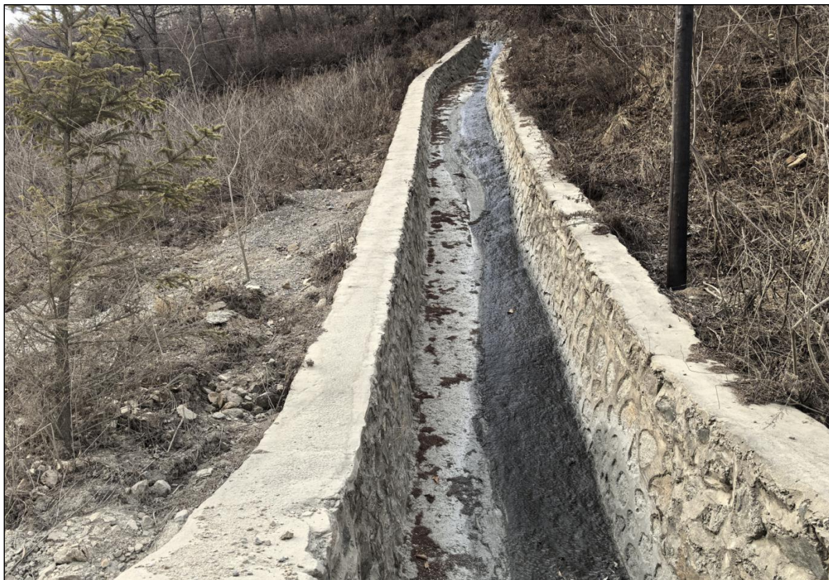
图 2-12 浆砌石衬砌段截洪沟
