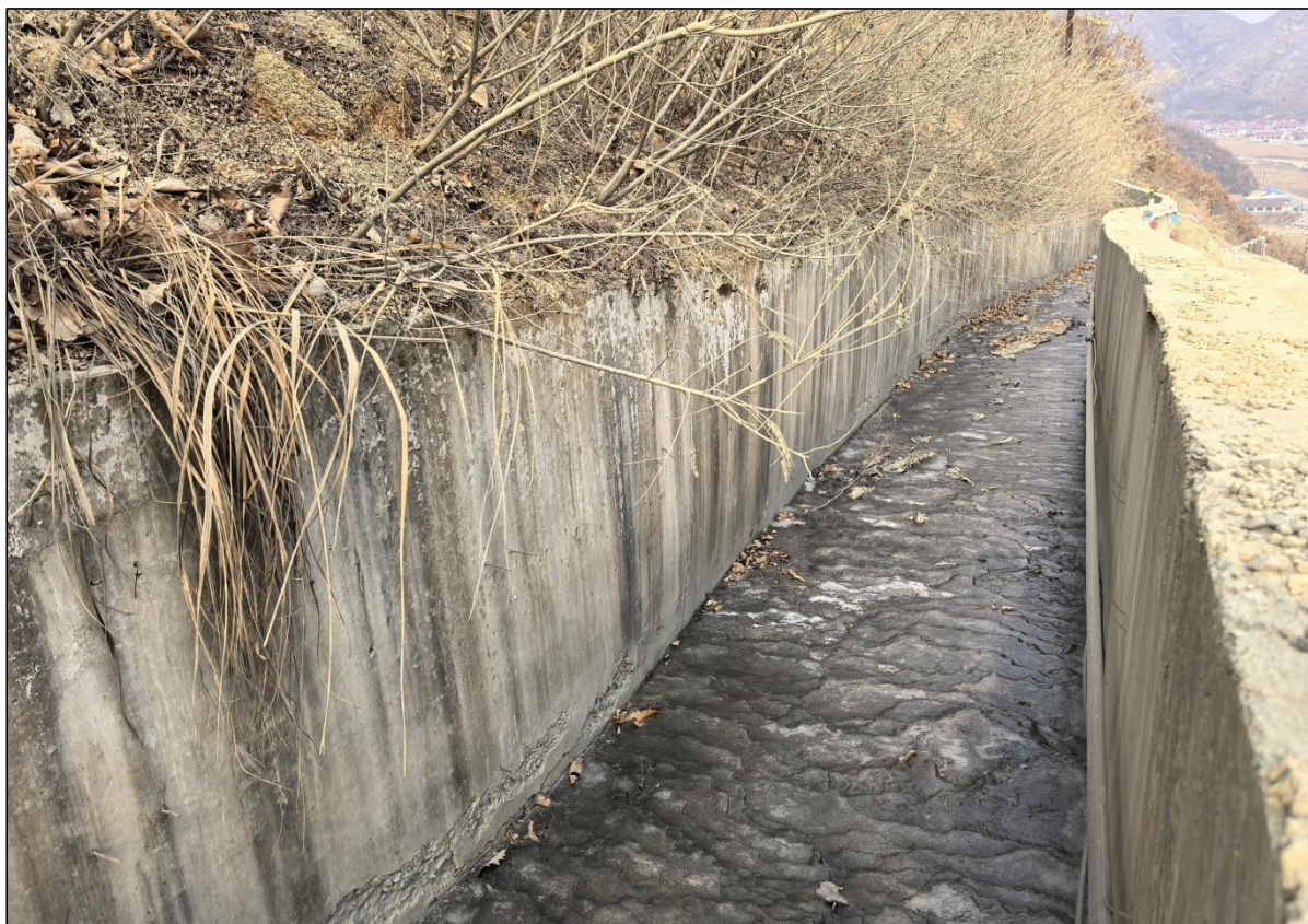
图 2-10 混凝土衬砌段
