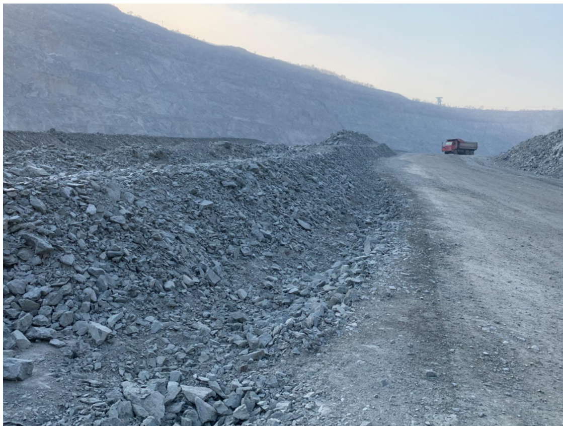
图 2-4 道路一侧设有安全车挡
