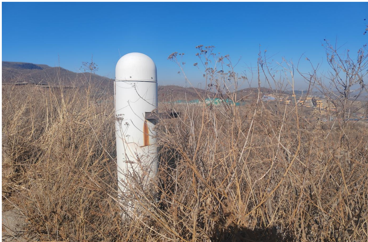
图 2-18 在坝体位移监测设施
