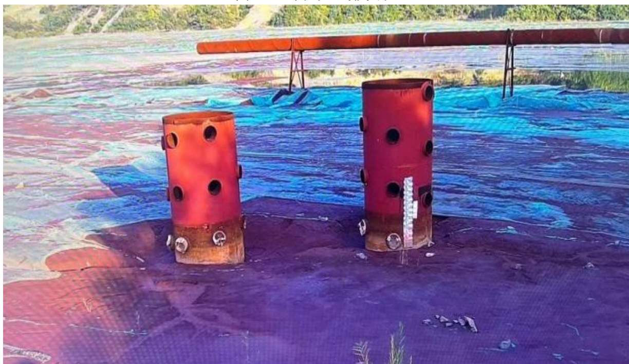
图 2-16 井峪沟钢塔-钢管导流设施
