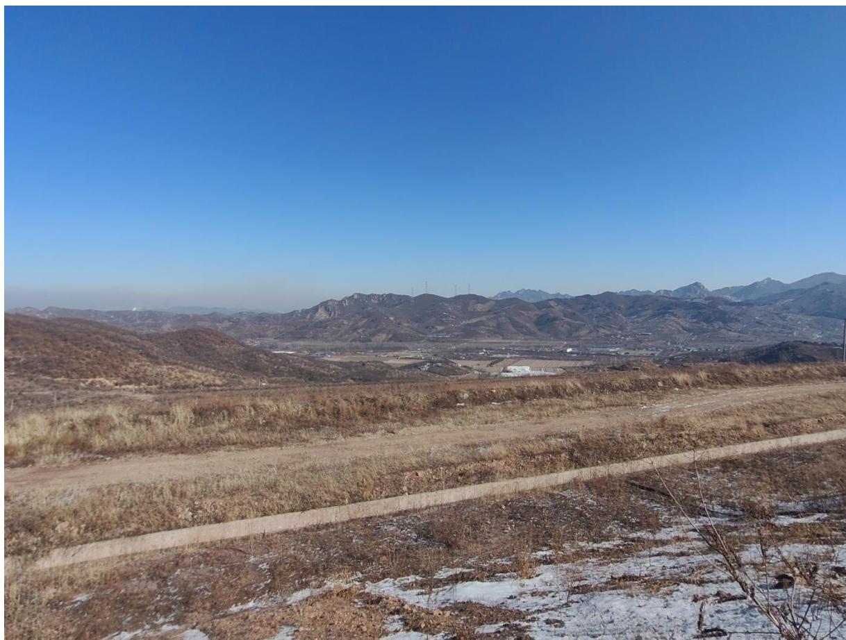
图 2-10 井峪沟坝外坡
