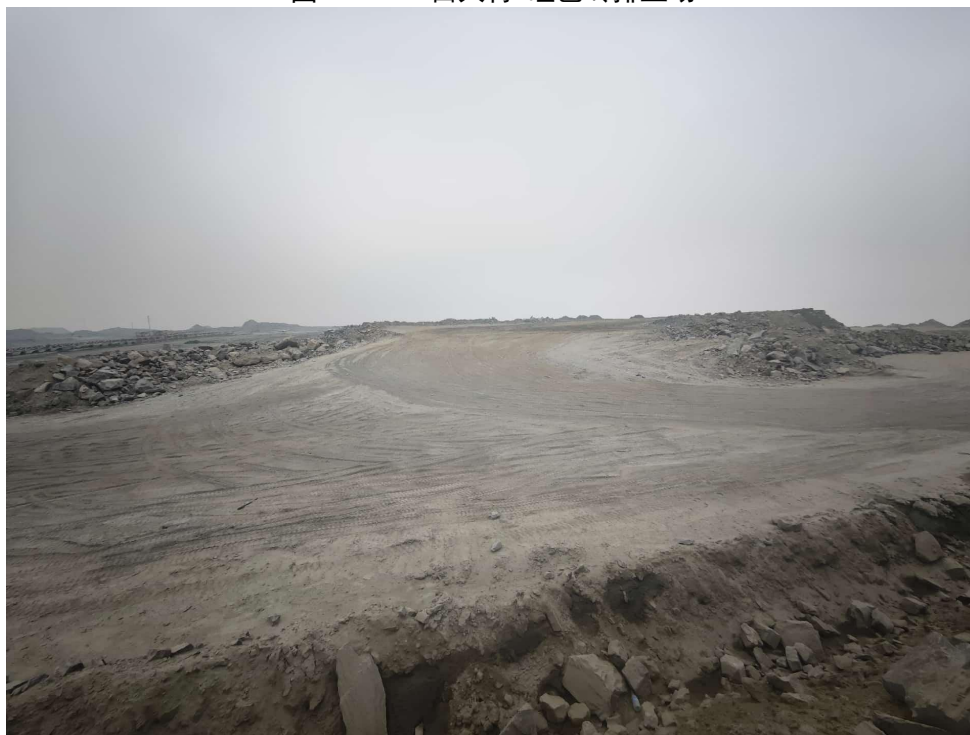
图2.5.2-7 排土场顶部平台
